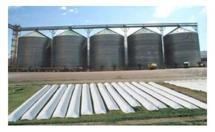
Figura 2: Sistemas de acopio: silobolsas y silos metálicos Extraído de Silos Córdoba (http://www.siloscordoba.com)
